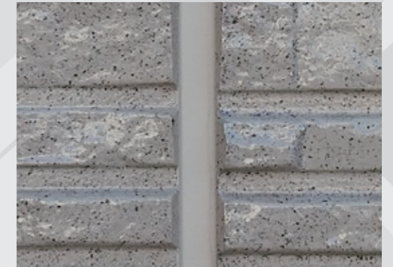
打ち替え後のシーリング材+外壁塗装
